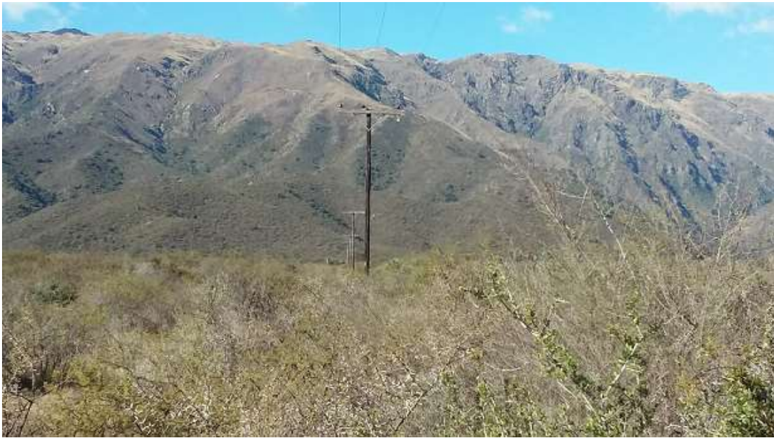
Foto 28. Tendido eléctrico entre la vegetación, en Los Molles (fotografía propia, julio 2016).
